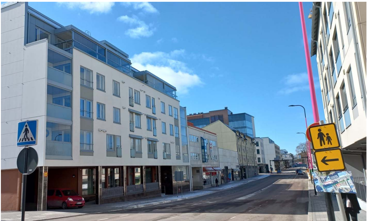
Kuva 54: Näkymä Koulukadulta lännen suuntaan, jossa vasemmalla äskettäin valmistunut Asunto Oy Arkadi, seuraavana oikealla Kiinteistö Oy Valtakatu 44:n kolmikerroksinen rakennus, seuraavana kaavamuutosalueen yksikerroksinen liikerakennus ja tämän takana neljäkerroksinen Asunto Oy Koulukatu 19, taustalla Kirkkokadun takana Osuuspankin seitsenkerroksinen liike- ja toimistorakennus. (Lappeenrannan kaupunkisuunnittelu 2024)
