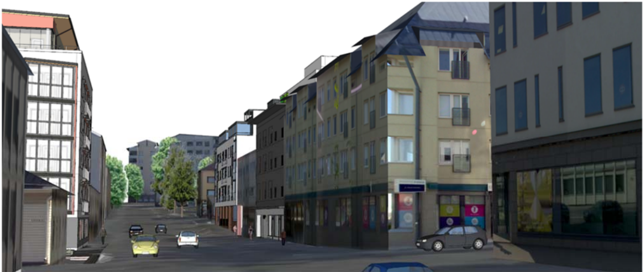
Kuva 46: Näkymä Koulukadulta, jossa oikealla Osuuspankki, seuraavana vasemmalla Koulukatu 19, seuraavana Valtakatu 42:n uudisrakennus, jossa viides kerros sisään vedettynä 3 metriä julkisivupinnasta olisi mahdollistanut vain 124 opiskelija-asuntoa. (Lappeenrannan kaupunkisuunnittelu/ Arkkitehtuuritoimisto Riitta ja Kari Ojala)
